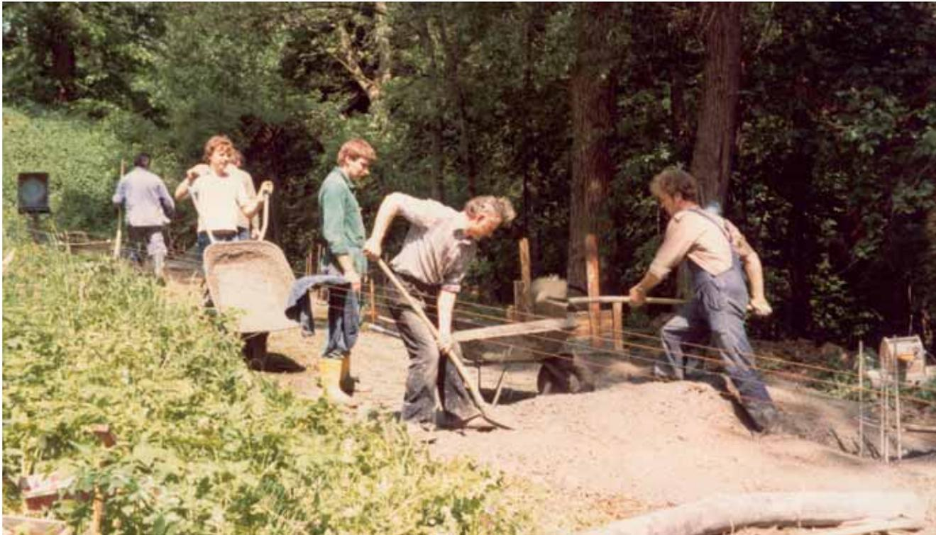
1981 – Ausgraben und Betonieren des Fundaments für die neue Seitenblende bis zum 100-m-Stand (22 Kubikmeter Beton).
