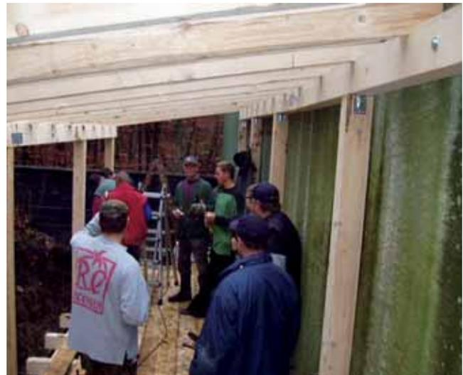
Bauaktion war im Jahr 2004 angesagt. Die Polywall-Kugelfänge vor der 50-Meter-Blende hatten ausgedient und für die neue Art von Kugelfängen in Form von großen Auffangbehältern, die hinter der Mauer platziert werden, musste Stellfläche und Überdachung angefertigt werden. Nach größeren Erdbewegungen war das Aufrichten nur noch Formsache.
